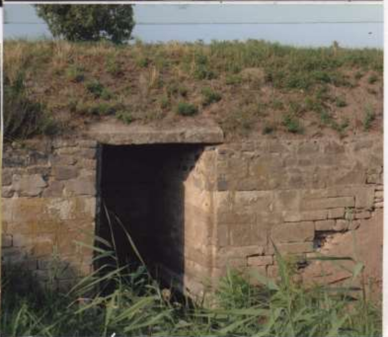
4. kép Az 1890-es években a Rima patak alatt átburjánzó Egerpatak zsilipje, a „sifony”, felette a „zúgó”
