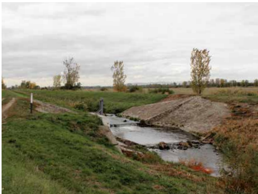
Két szintelosztással kereszteződő csatorna
