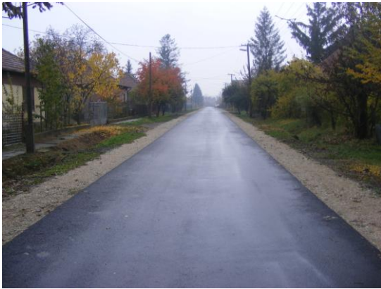
A Kandó Kálmán és Dobó út felújítása, aszfaltozása elkészült
