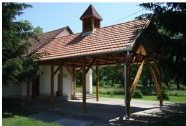
Ravatalozónk elé előtető épült
